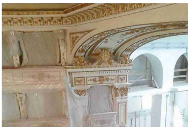
Uno scorcio dell'interno del teatro comunale a lavori in corso
